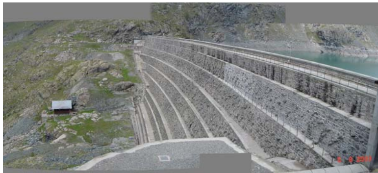
Fig. 9 – Diga del Gabiet
