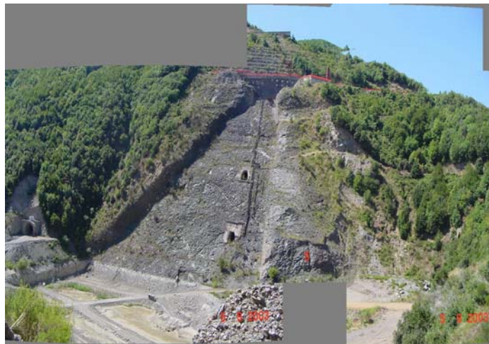
Fig. 5 – Impronta destra della diga di Esaro
