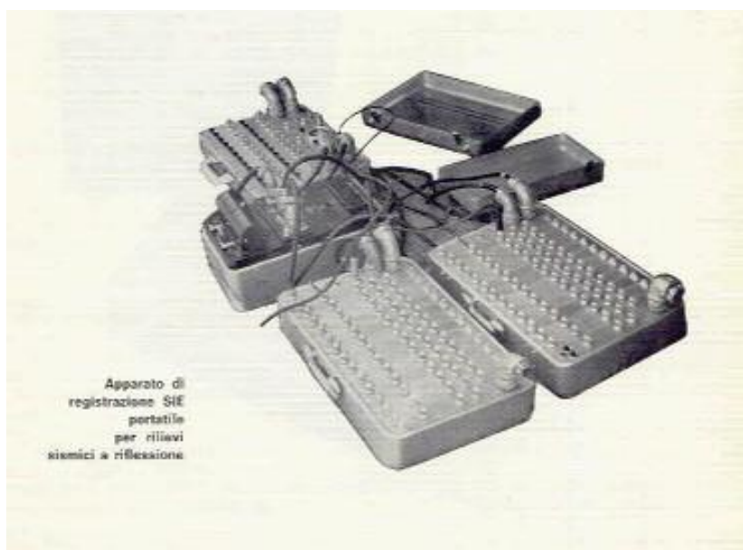
Fig. 1 – Sismografi per rilievi a riflessione degli anni '60-'70.
